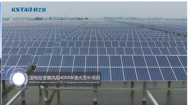
安徽凤阳 40MW 渔光互补光伏发电项目
