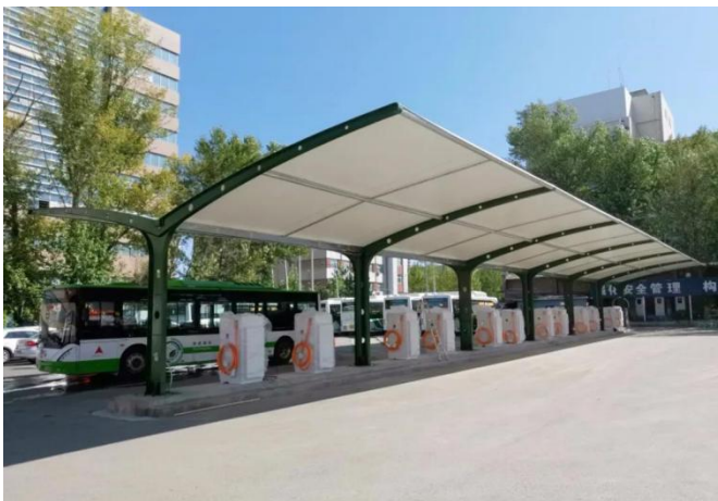
长春公交集团东锦路 119 路充电站
